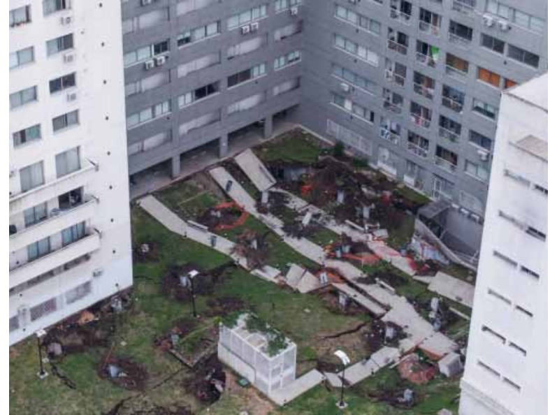
"Estrago". Vista aérea del techo derrumbado. - NA -
